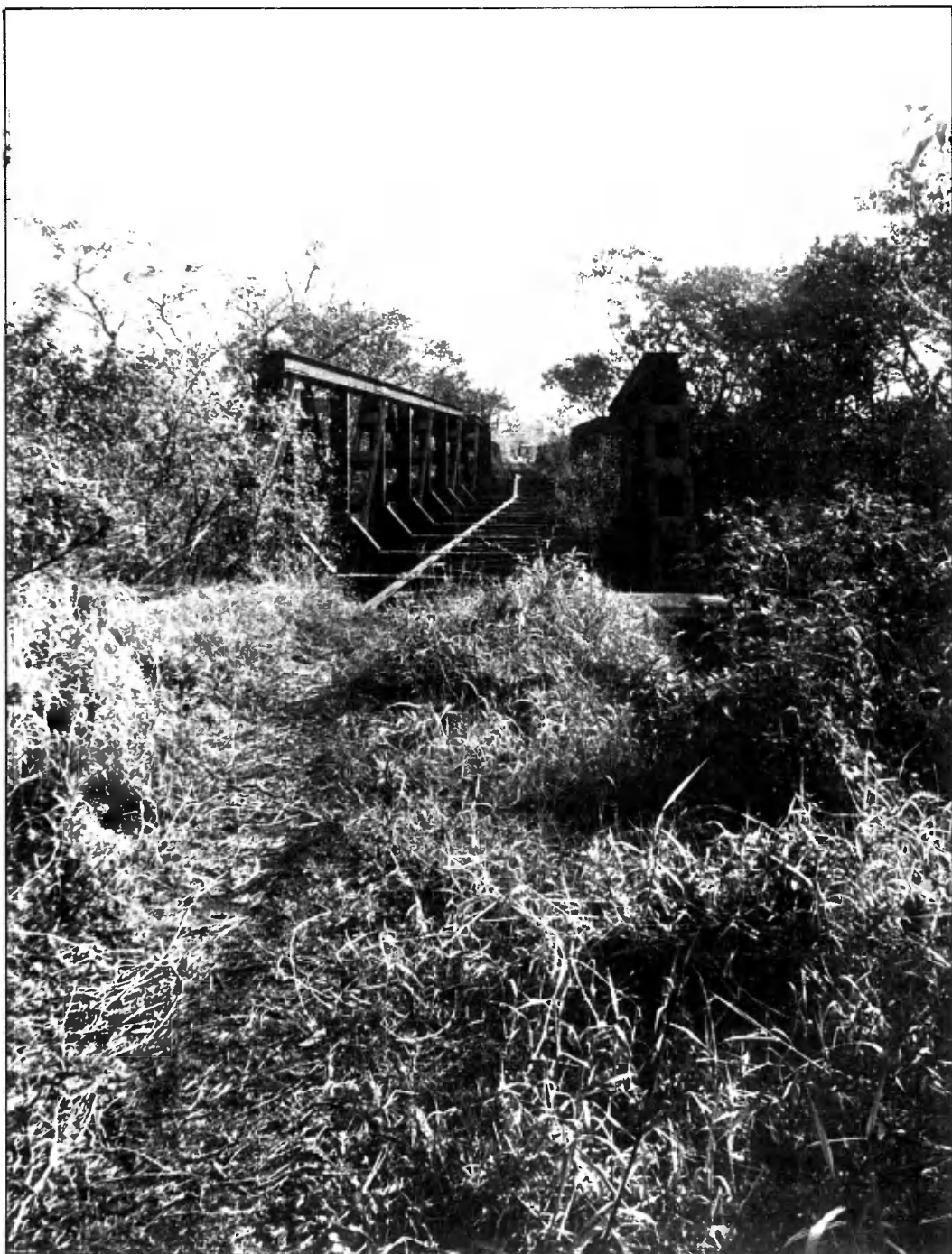
A velha ponte de ferro sobre o rio.
